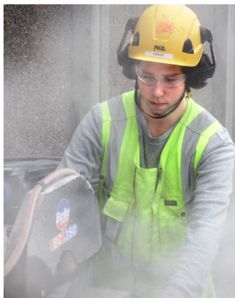
Toisen vuoden opiskelija Eeli Haikka suorittaa muurauksen tutkinnon osaa, johon kuuluu kahi-tiilen leikkausta tiilisahalla.
